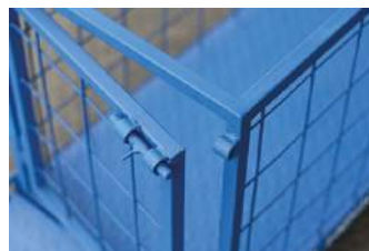
Калитки, оснащенные шпингалетами.
